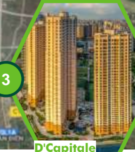
D'Capitale - C5 Tower NLA: 12.000 m 2
