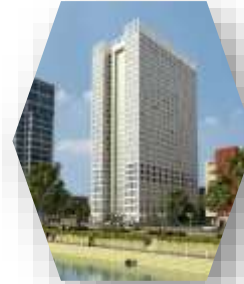
Lancaster Luminaire ~300 căn
